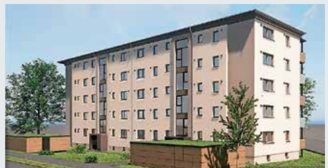
Beispielhaftes Foto des Gebäudes nach Sanierung
